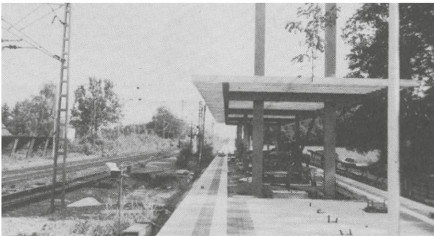
Am Bahnhof Erzhausen sind am Bahnsteig der S-Bahn neue Fortschritte zu erkennen. Die Überdachung der Treppe, des Aufzuges und eines Teils des Bahnsteigs, der schon mit Verbundsteinen belegt ist, steht vor der Vollendung. (Text und Foto: ez)
