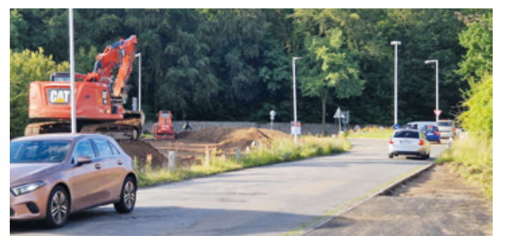
Für die neue Einmündung der Jägertorstraße in die Kranichsteiner Straße wurde mit vorbereitenden Erdarbeiten bereits begonnen. Die neue Einmündung erfolgt weiter östlich, auf dem Foto links von der bisherigen Jägertorstraße, die während des Kreuzungsausbaus in beiden Richtungen weiter befahren werden kann. (Foto: dv)
