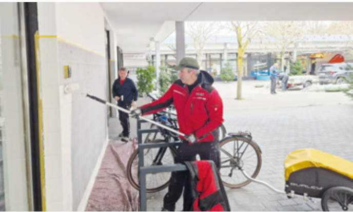
Ein neuer Anstrich hübscht das alte EKZ auf, für Weihnachtsbäume hat der Gewerbeverein gesorgt, das „Chillai“ (im Hintergrund „zu vermieten!“) ist inzwischen vermietet. (Foto: dv)
